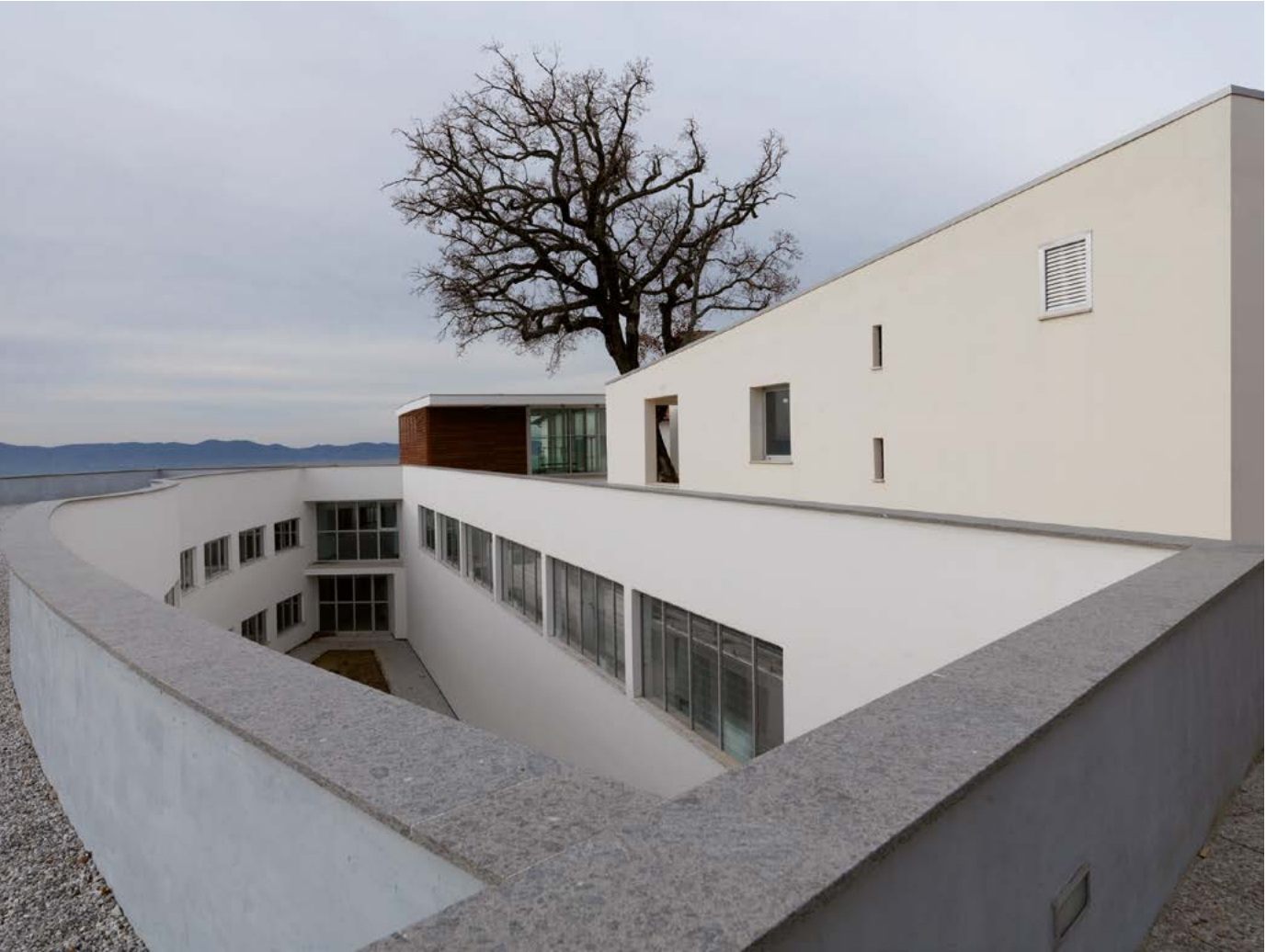
IN QUESTE PAGINE: VISTE DELLA COPERTURA IN THESE PAGES: VIEWS OF THE ROOF
