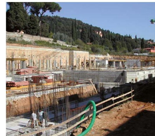
FASI DEGLI SCAVI E DELLA REALIZZAZIONE DELLE FONDAZIONI EXCAVATION AND FOUNDATION CONSTRUCTION PHASES
