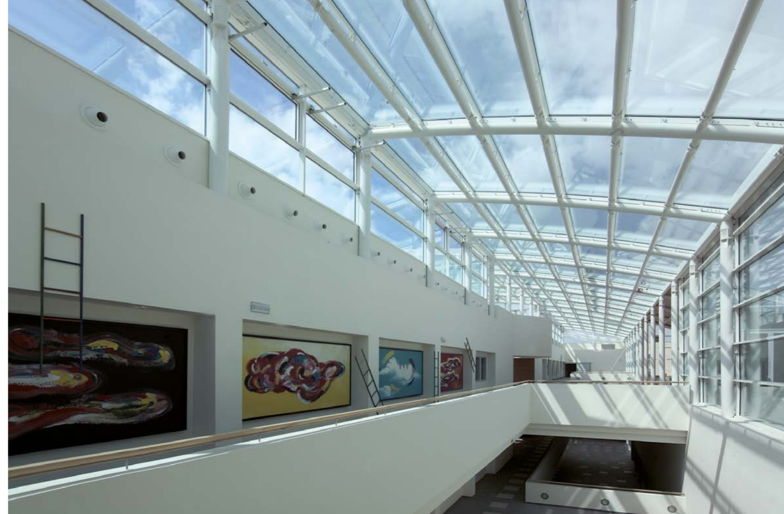
LA STRUTTURA METALLICA NELLA PARTE NORD THE NORTHERN AREA STEEL STRUCTURE
